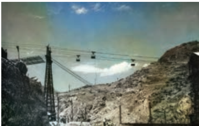
Şəkil 7. “Quşçu Körpü” stansiyası. Dəmir filizi konsentratının yüklənməsi
